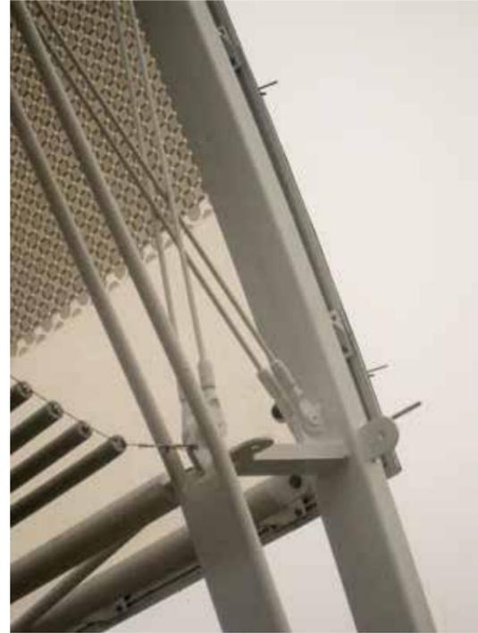
Détail du prototype de la structure avec les coussins ETFE en place.
