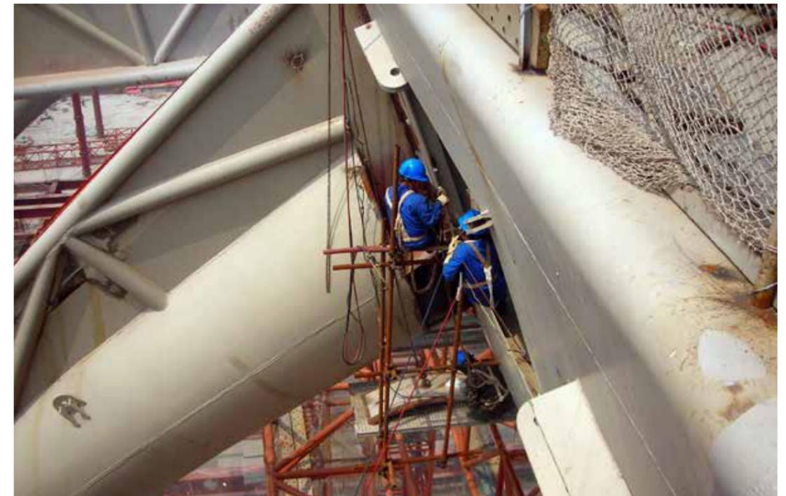
Photo de la façade Est pendant les travaux, avec les pieds inclinés reprenant les poutres de toiture encastrees à l'arête centrale.
