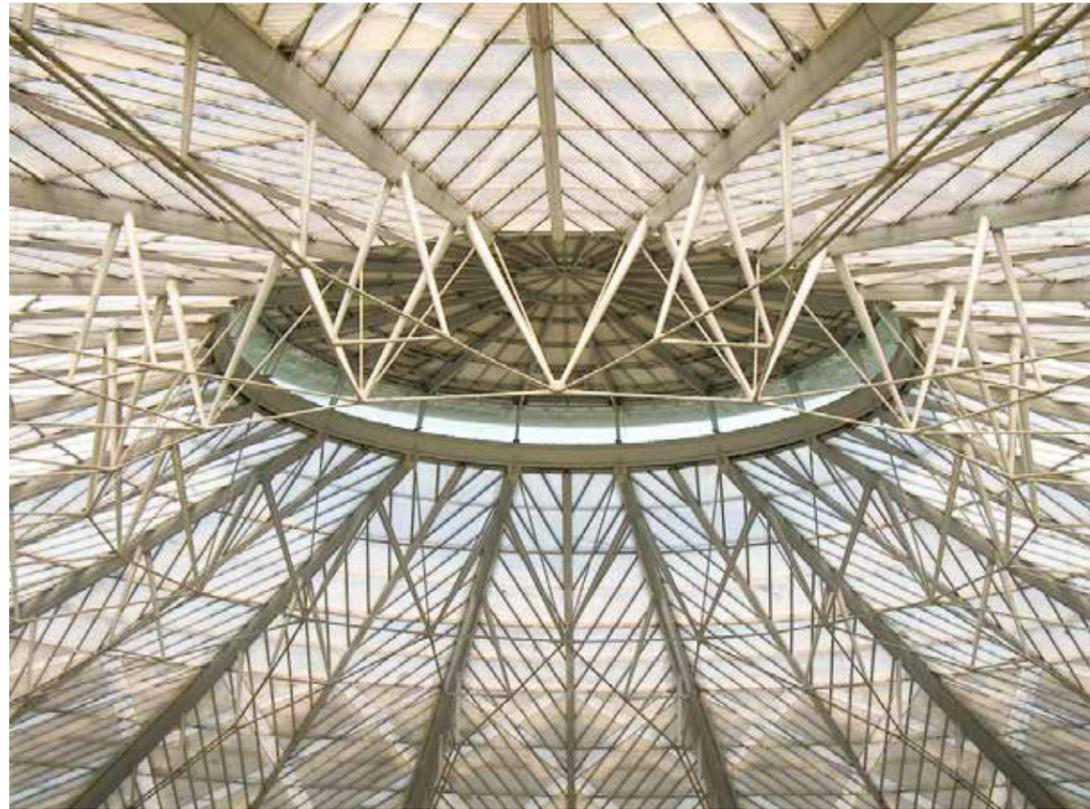
Les 18 poutres se rejoignent sur un anneau central qui reprend une compression de 2000 tonnes. Les sous-tension des poutres principales se raccordent également pour former un moyen de stabiliser l'anneau au flambement hors plan. Cet anneau sous-tendu d'une grande rigidité en torsion permet d'encastrer les extrémités des poutres vis-à-vis des charges dissymétriques.
