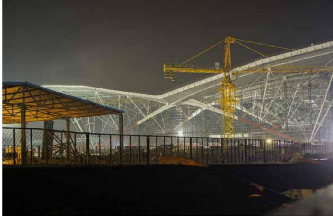
En section longitudinale, (figure 3), les bracons forment une suite de « V », supportant la toiture. Dans la partie centrale de la gare, où le rythme des arcs n'est que de 22 m, les extrémités des bracons se rejoignent, pour former une structure très rigide en double « W », qui agit comme un noyau de contreventement longitudinal. Ce noyau qui se trouve au centre de la structure laisse celle-ci se dilater sous l'effet de la température.
