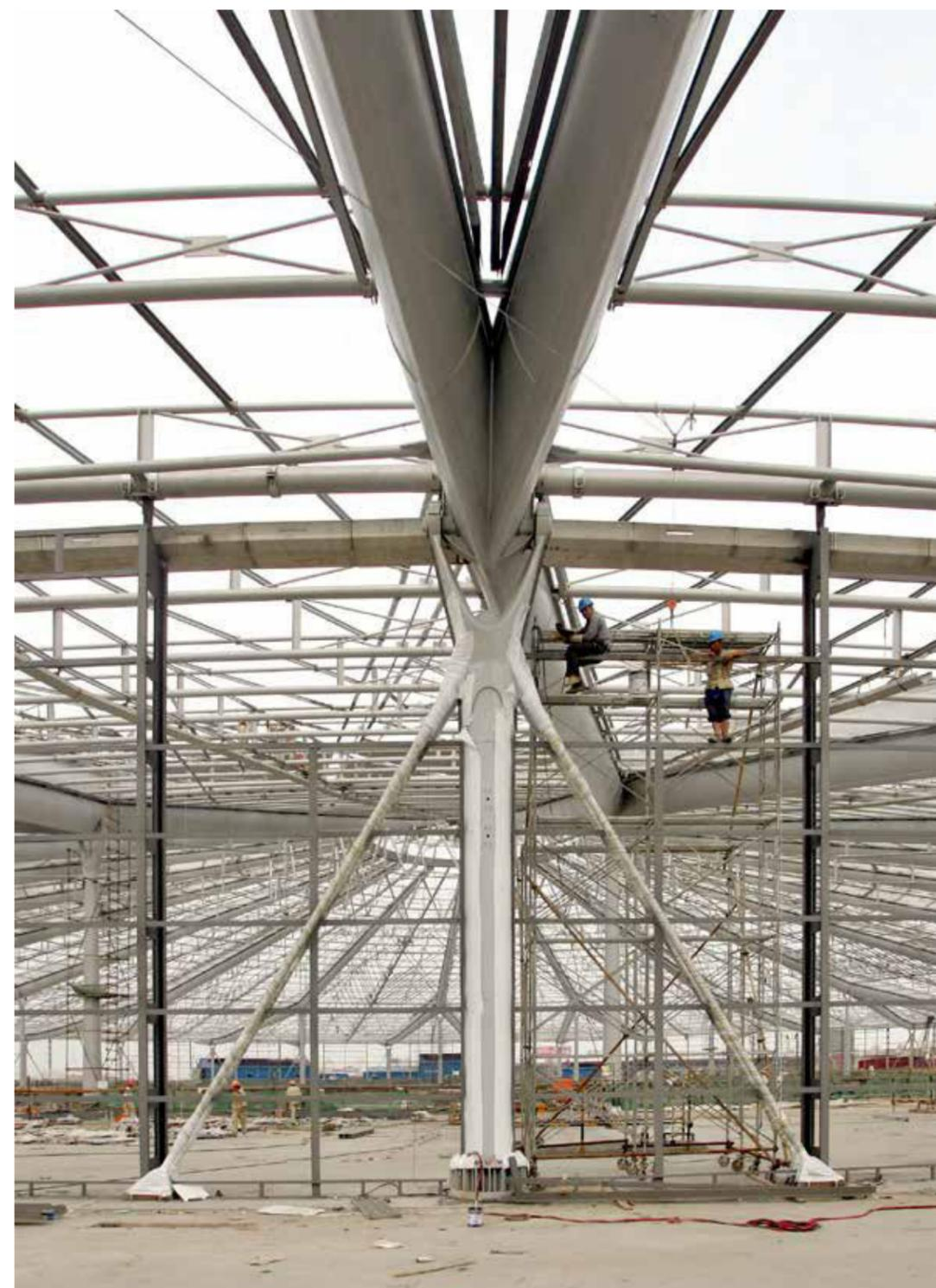
Les grandes poutres en tôle pliée viennent s'articuler sur des pièces moulées en fûte de 18 poteaux intérieurs et de 36 poteaux périphériques. Les poteaux périphériques sont munis de tirants inclinés pour le contreventement de la toiture. Ce système de contreventement orthoradial reprend les efforts sismiques très importants à Shanghai tout en laissant le dôme se dilater sous l'effet de la température (+/- 30 mm).
