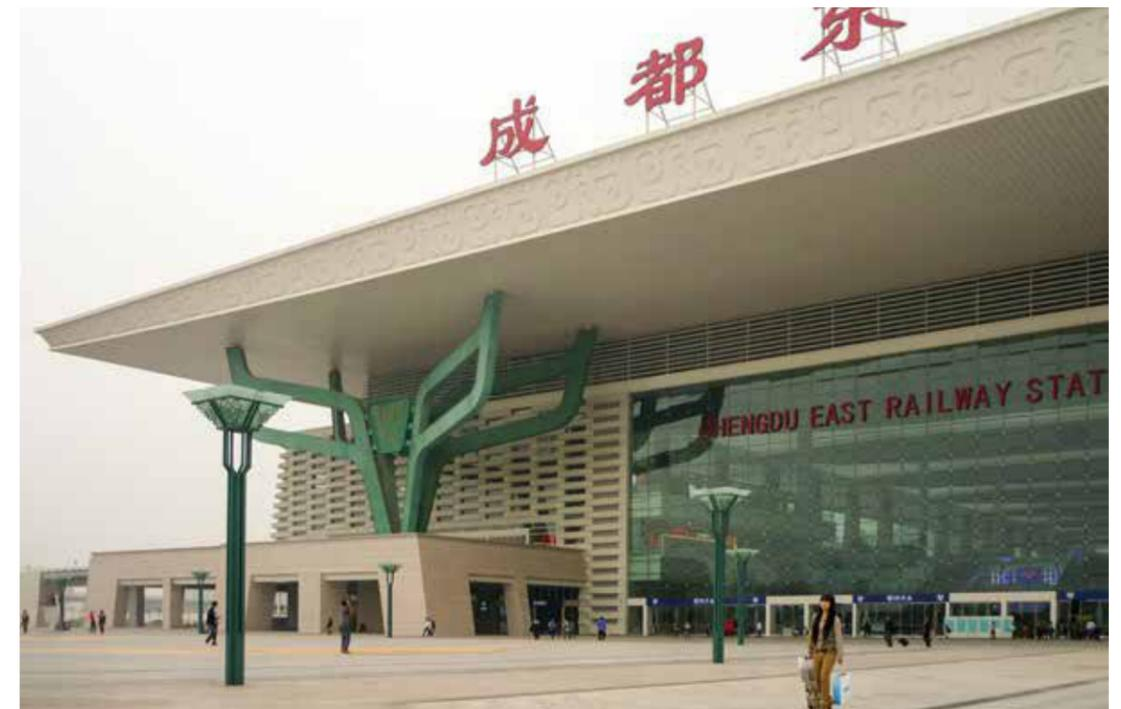
Vue de la façade côté voies ferrées, avec les piles espacées de 23 m.
