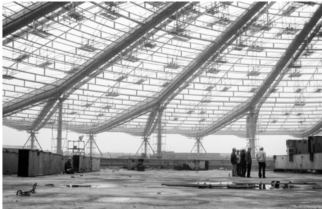
Méthode de montage de la structure, utilisant un " pont roulant " circulaire.
