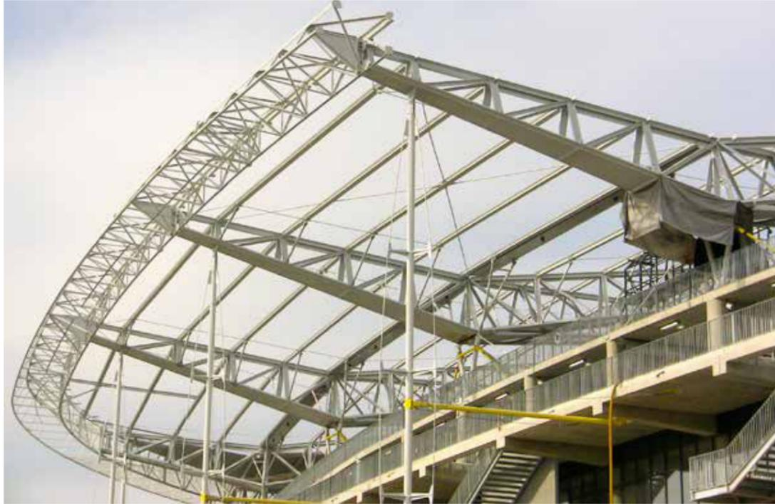
La toiture sud s'appuie sur des poteaux sous tendus par des câbles paraboliques. Ces poteaux ont été fabriqués avant ceux, similaires de la gare de Qingdao, servant ainsi de test.
