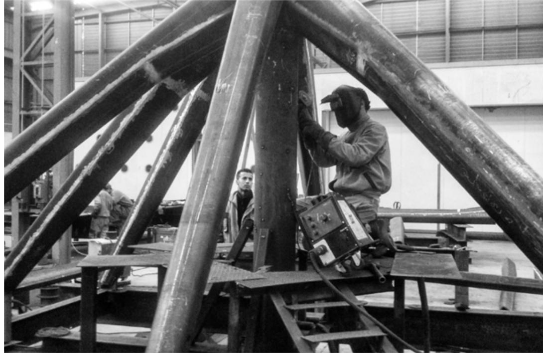
Les 40 corolles sont réalisées en tôle pliée de 12 mm d'épaisseur. Chaque branche est formée de 3 tôles soudées sur un cône en acier moulé.
