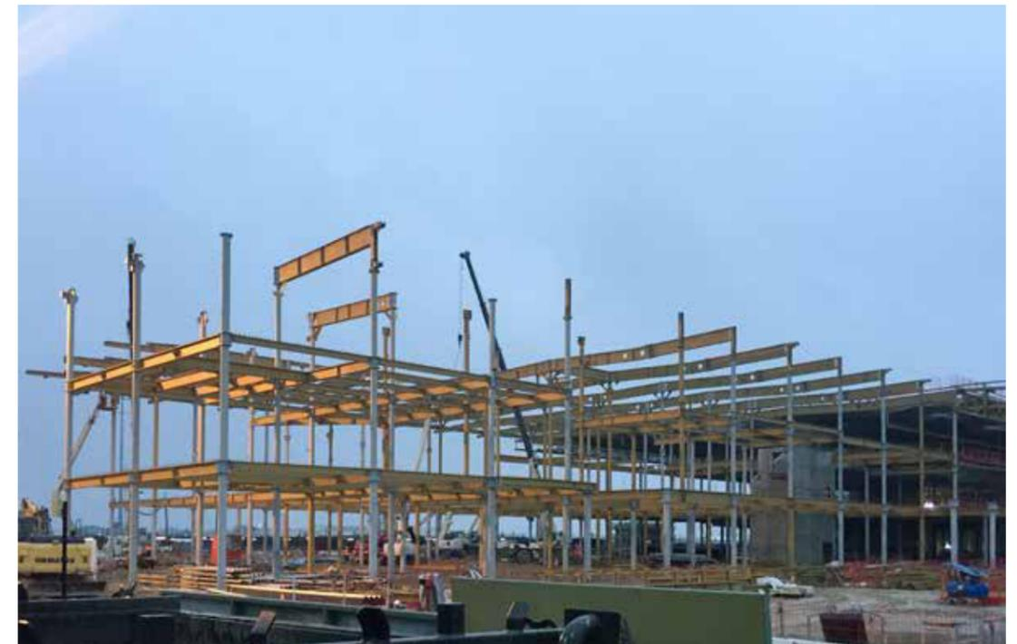
Vue de la structure en travaux : Les poteaux mixtes du hall ont un élancement de 33 (320 mm de diamètre pour 12 m de hauteur).
