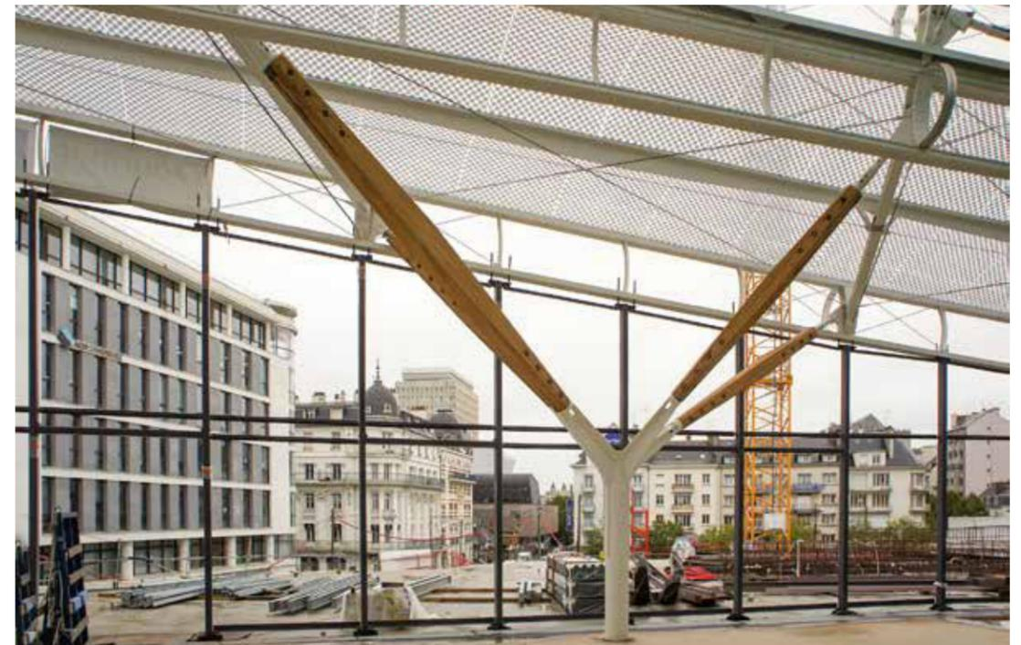
La couverture en ETFE est munie de rives tubulaires gonflées enveloppant entièrement la structure pour donner une impression de brume voulue par l'architecte. Des ouvertures vitrées ouvrent des points de vue vers l'extérieur. Les poteaux arborescents ont des branches en chêne lamellé collé travaillant en compression simple.
