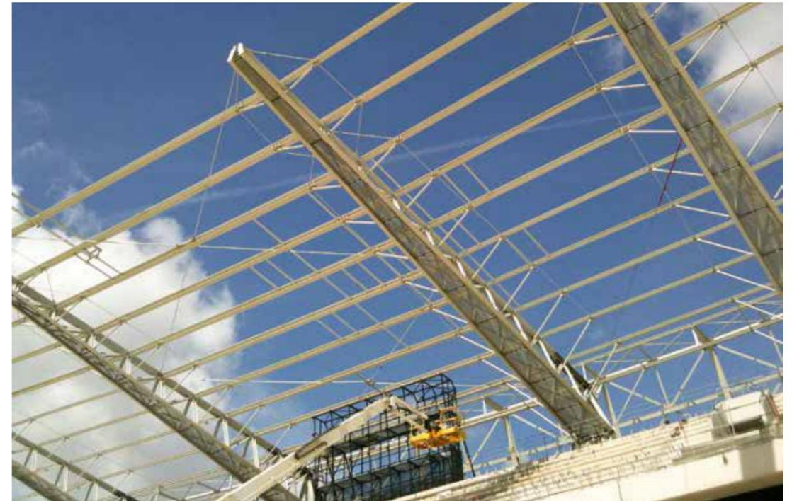
Poutres de toitures en treillis cornière, 2 faces peintes et une face galvanisée intégrant une passerelle d'accès en métal déployé. Des bracons soulagent la portée des pannes, pour les affiner au maximum.
