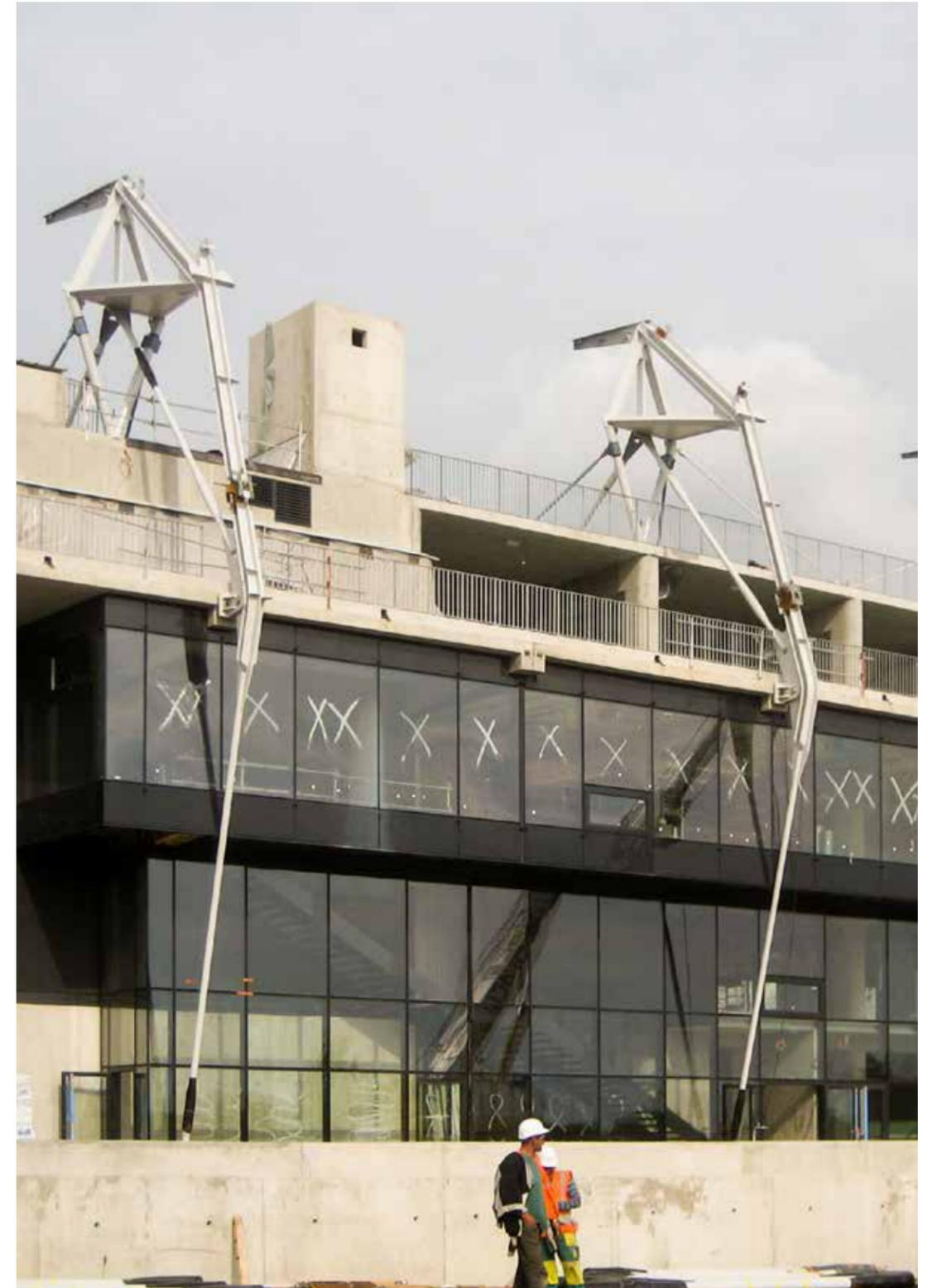
Vue des tirants d'ancrage de diamètre 120 mm en façade.
