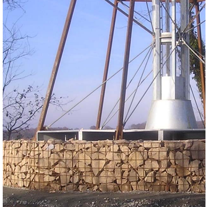
Massif – fondation creuse lestée par des gabions
