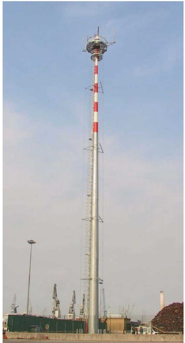
Pylône en place sur site (50 m de hauteur) port de Montfalcone avec antennes et radar en tête
