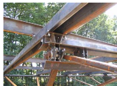
Montage à blanc détail faîtière
