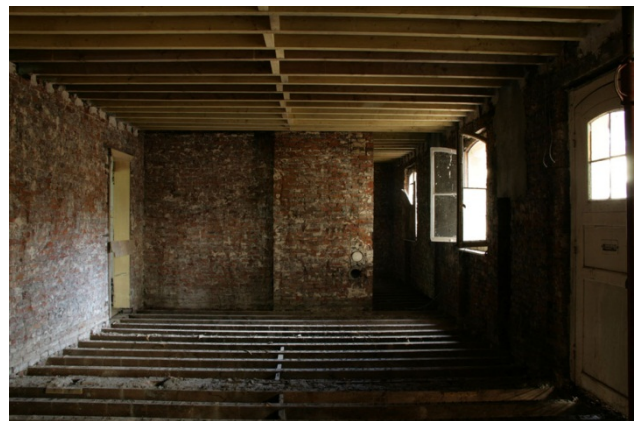
étage courant décroisonné – plancher bois conservé
