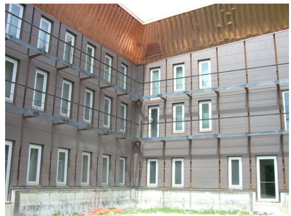
Façades sur la cour intérieure – toiture en cuivre
