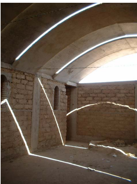
vue intérieure pendant les travaux
