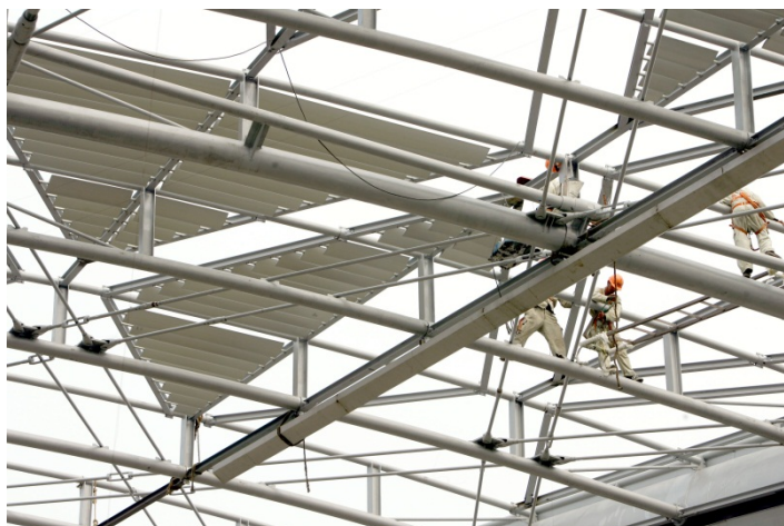
Gare de Shanghai Sud – Chine réalisée en 2006
